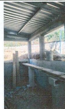
Foto 2: Mejoramiento de repello de aula tipo portico por ambos lados y mejoramiento de pintura
