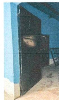
Foto 6: Sustitución de chapa del aula
