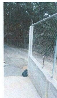
Foto 4: Sustitucion de porton
